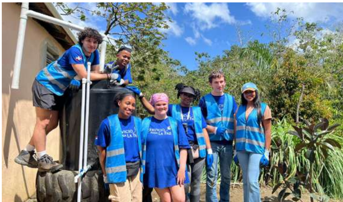
Instalación de Tinacos.
